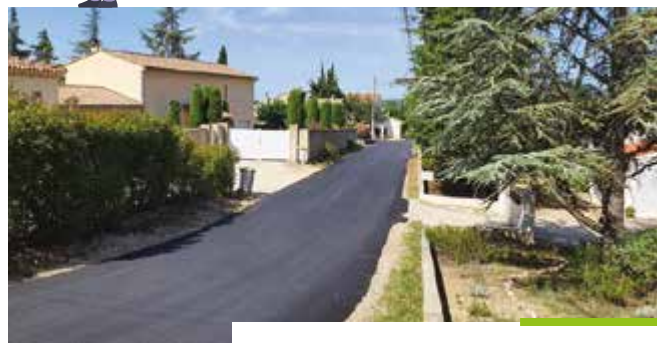
CHEMINS DE LA FERRAILLE, DE LA GARENNE, REMIS EN ÉTAT ET REPRISSE DES ENROBÉS
